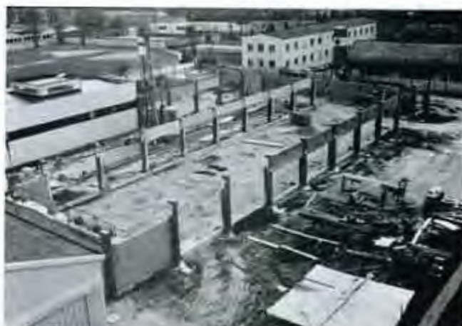
02.04.86 - Longrines, acrotères maçonnerie réalisés à 95 %
