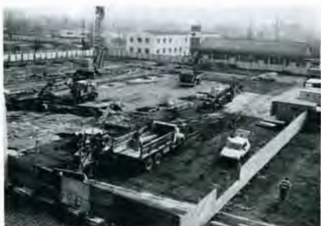
04.02.86 - Terrassements et fondations terminés
