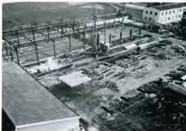
05.03.86 - Poteaux et longrines en cours
