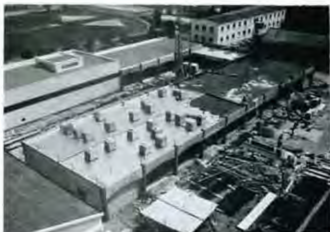
12.05.86 - Planchers, hérisson, toiture réalisés à 95 %
