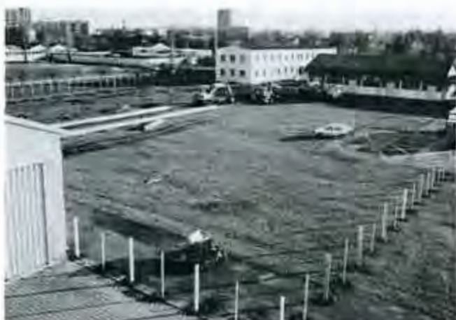
06.01.86 - Mise en place de la clôture Aménagement du chantier
